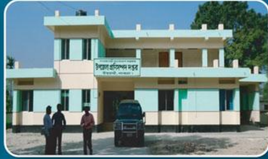
নবনির্মিত উপজেলা ভবন ঈশ্বরী, পাবনা
